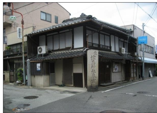
橋詰三叉路の道標
