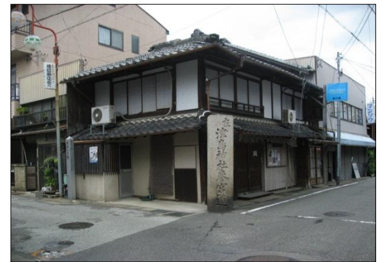
橋詰三叉路の道標
